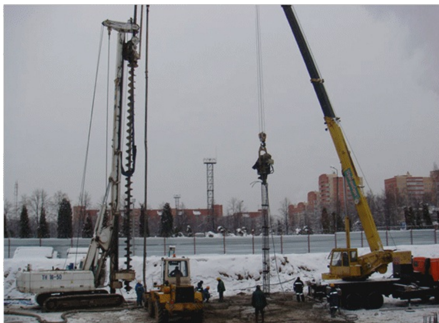
Рис.6. Погружение арматурного каркаса в скважину заполненную бетоном
